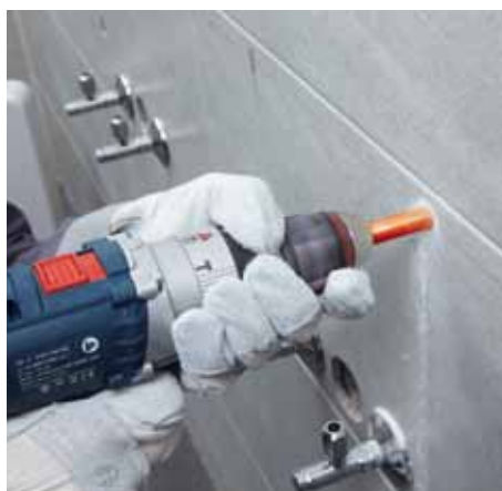
Suho vrtanje z Easy Ceramics diamantnim samohlajenim svedom.
